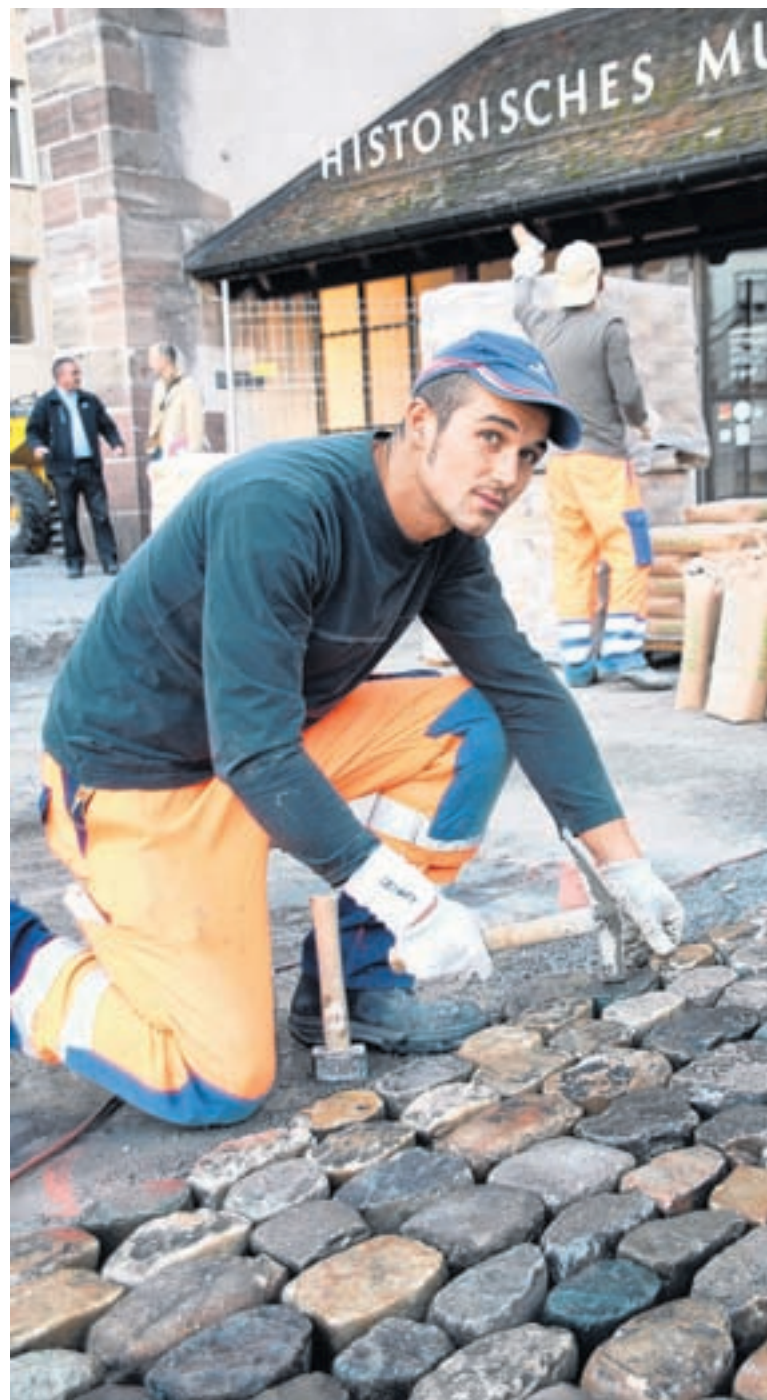
Gerade Reihen. Benjamin Epple hat den Boden vor der Barfüsserkirche neu gepflästert. Foto Elena Monti
