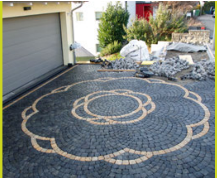
Langlebiges Schmuckstück auf dem Vorplatz: strahlenförmig aufgeweitete Bogenpflasterung aus Basalt und Granit.
