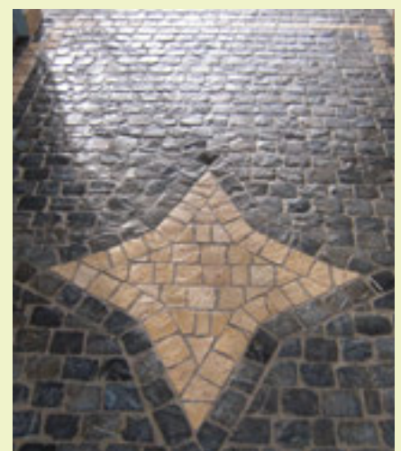
Stern aus farbigen Kalksteinen in Pflasterung aus Basalt.
