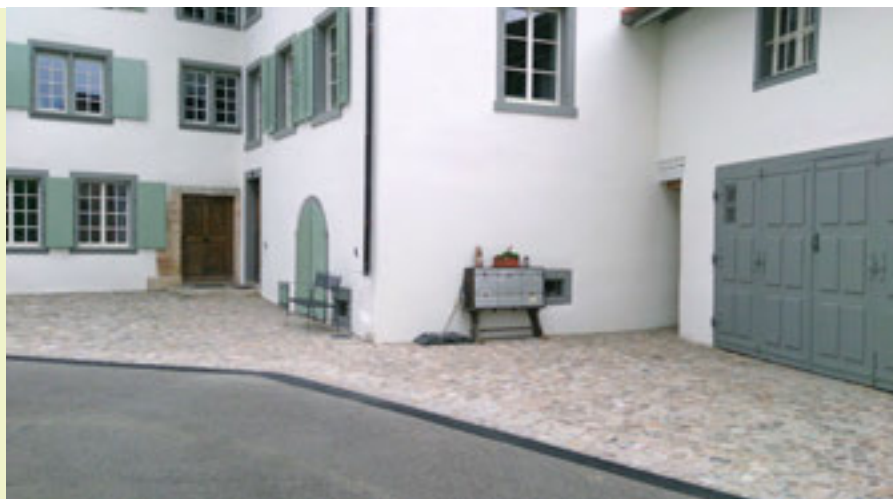
Reihenpflasterung aus Kieselwacken, die traditionellste Verlegeart im Raum Basel.
