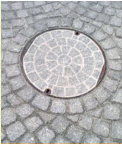
Wichtige Details: Schachtdeckel aufgepflastert.
