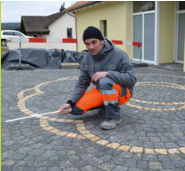
Benjamin Epple erklärt das Prinzip der aufgeweiteten Bogenpflasterung.
